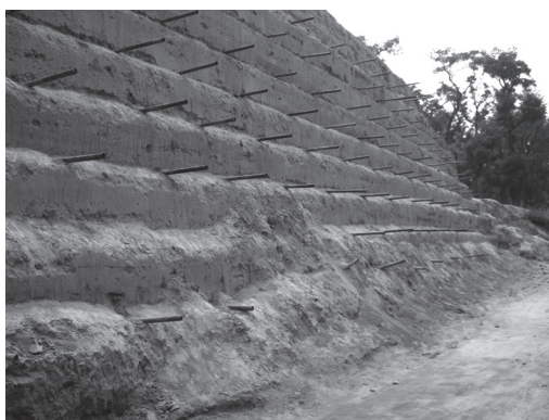
図12 鄭州商城復元城壁(版築法)
