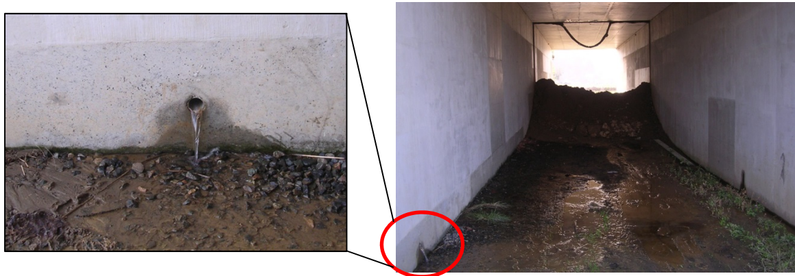
図-5.39 新潟県中越地震で被災した粘性土地盤上の高速道路盛土のボックスカルバート ～カルバートの水抜き穴より湧水している様子～ (地震発生：2004 年 10 月 23 日，写真撮影：2004 年 11 月 5 日) (写真提供： NEXCO 中日本（株）の稲垣太浩氏)
