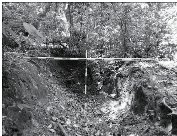
写真－4 粘土採掘の坑道が落盤してできた凹部
