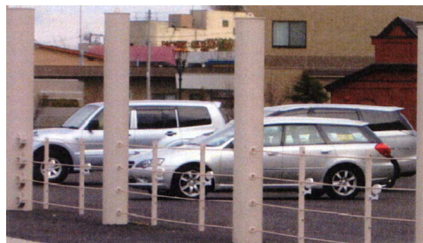
(d) Tsunami screen at Kushiro region Source: Maruyama et al. 2008
