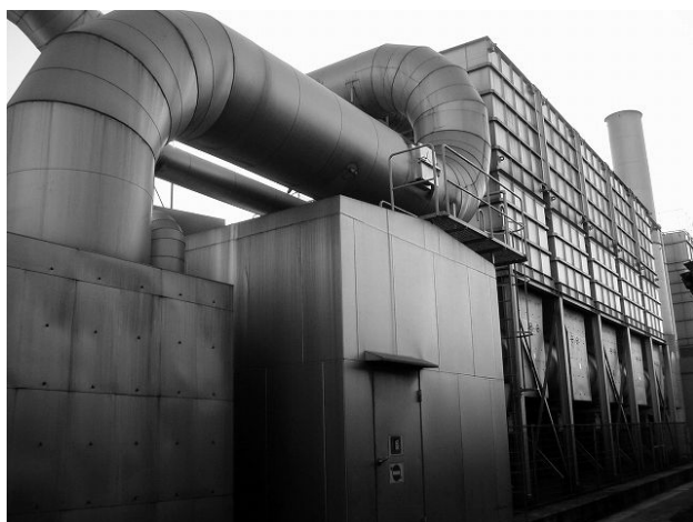
Fig. 2-3 RTO 外観写真
