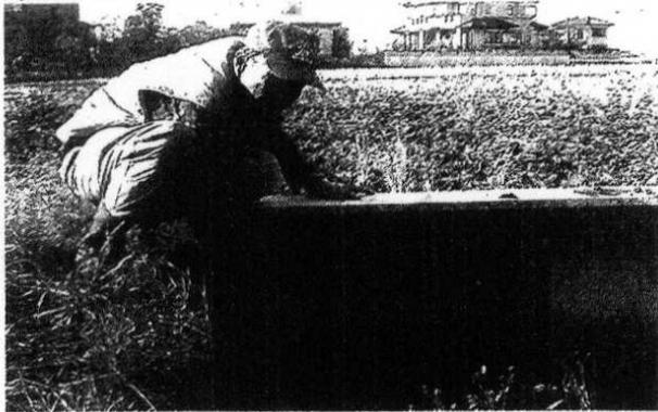
地盤が沈下してかさ上げされた用水路。くっきり工事跡がのこっている＝いずれも日立市で
