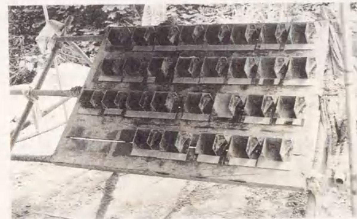
図 4.1: 立方供試体の型わく設置状況
