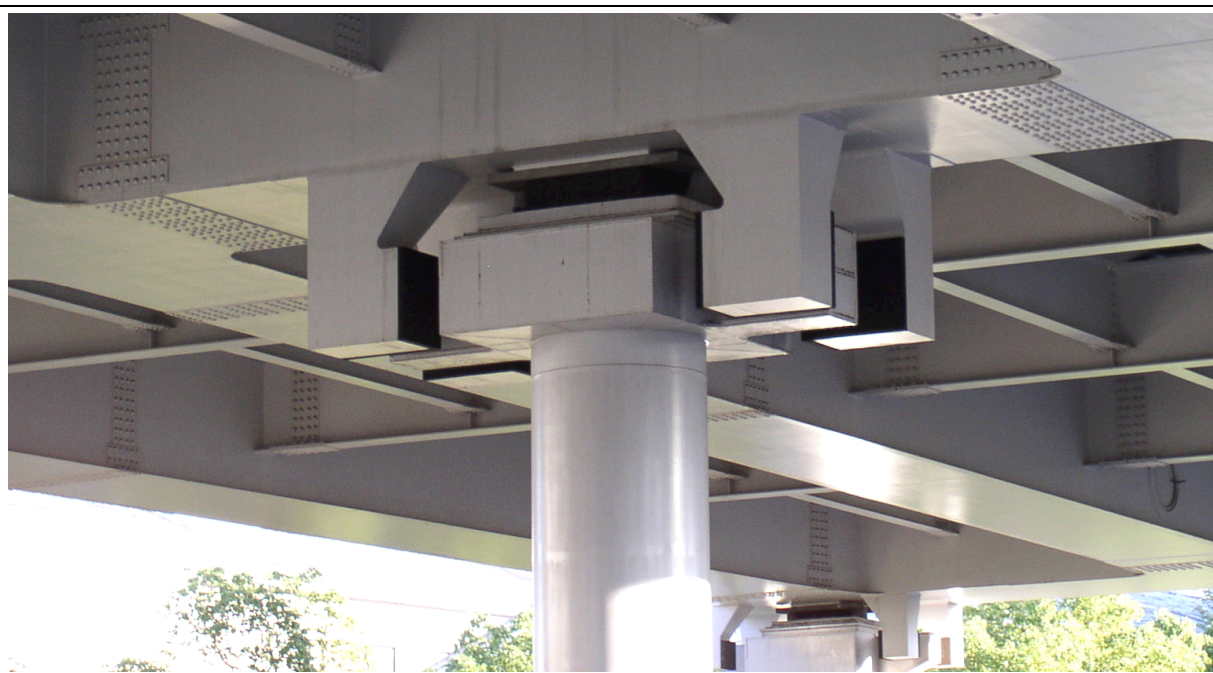
図1. ガイドウェイ・バス大曾根駅の免震構造の例。上の台と柱の間に見える黒い板が免振バネ。
