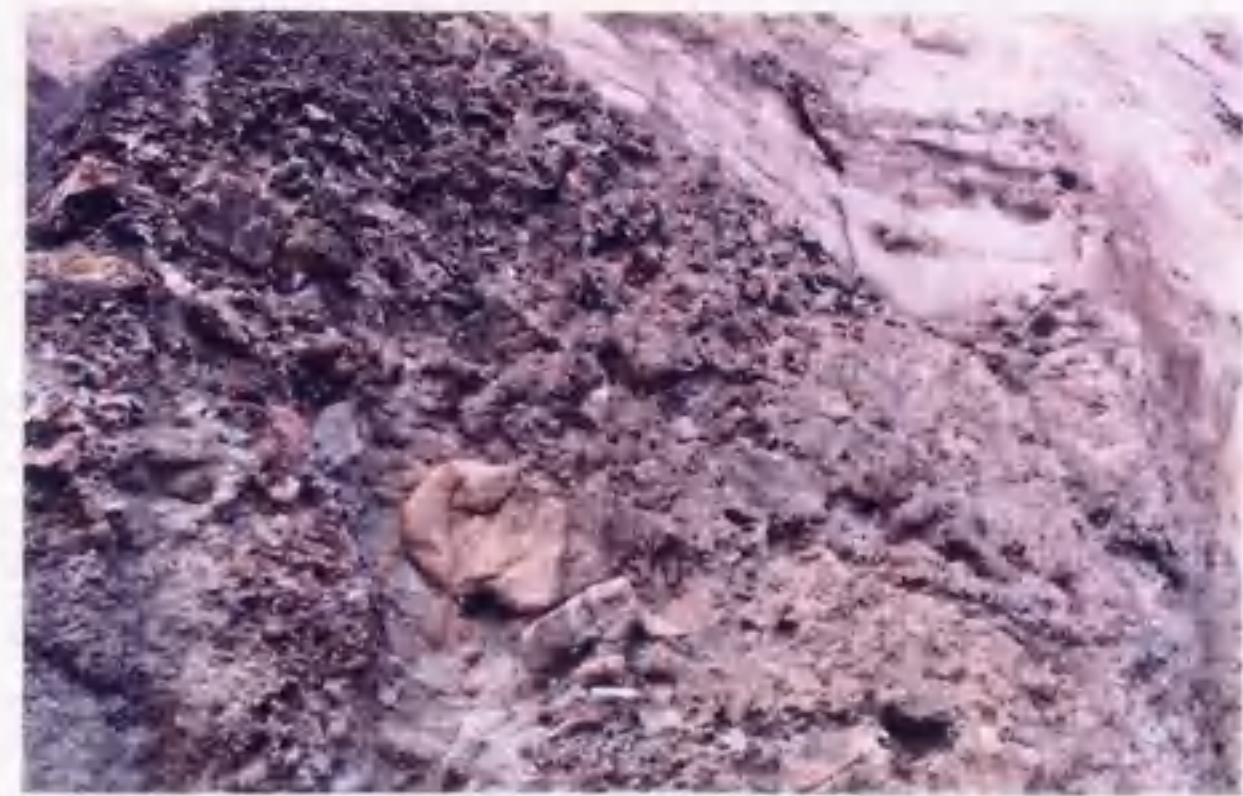
写真 8.7 凝灰岩の風化状況
