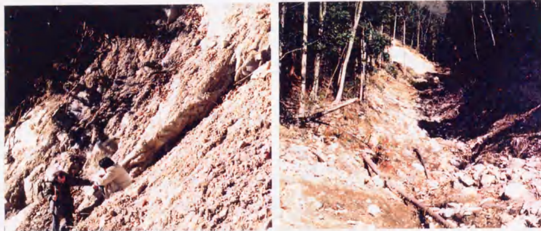
写真 8.5 集中豪雨による崩壊現場
