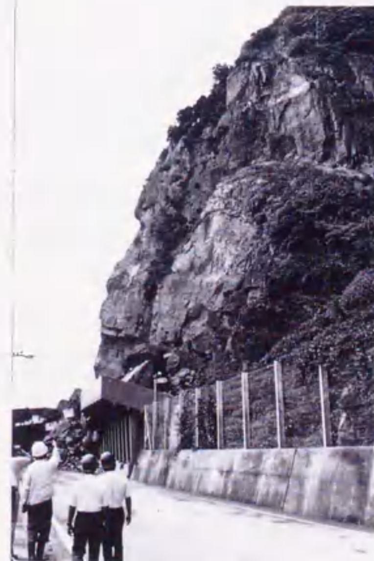
トッピング破壊 凝灰岩（福井県越前町）
