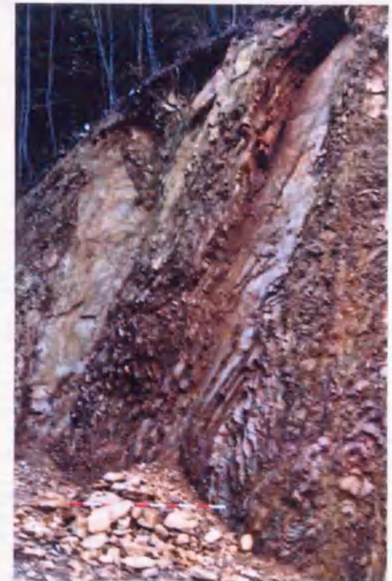
くさび形すべり破壊 砂岩・頁岩（岐阜県八幡町）
