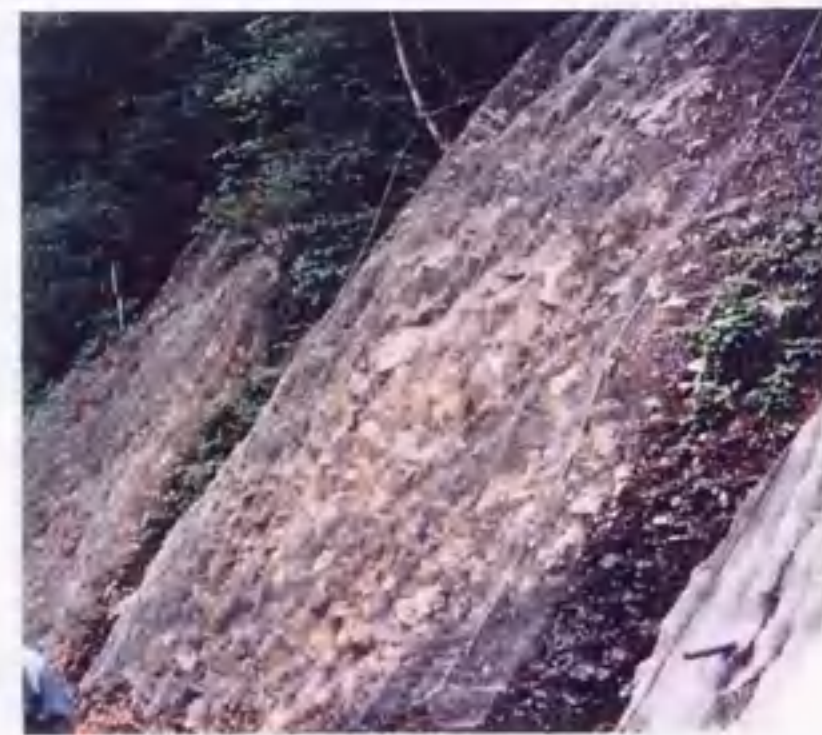
写真 8.3 掘削施工が完了した斜面
