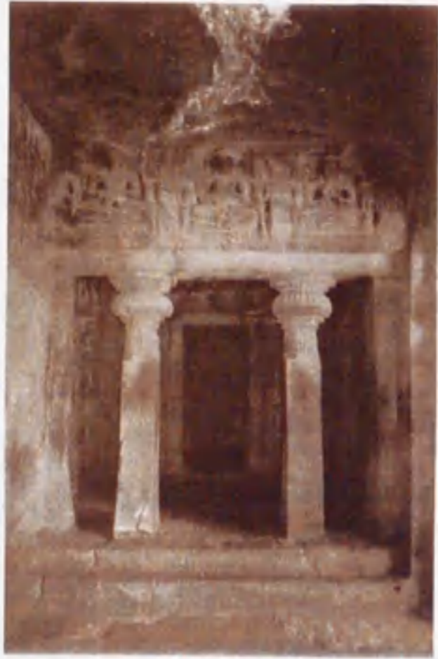
写真 II-1-18 エローラ第10窟ヴェランダ ブツダ像小祠堂前室前面（クッション柱）
