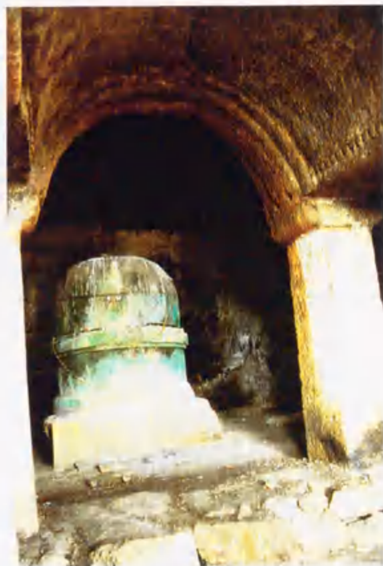
写真1-3-3 ボラトゥンガル PO-a ホール内部
