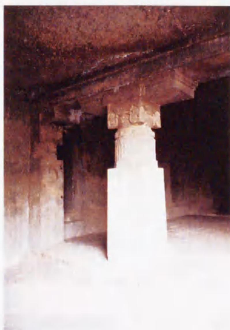
写真 II-1-10 エローラ第8窟ホール前面 (壺葉飾り柱とコンポジット柱)
