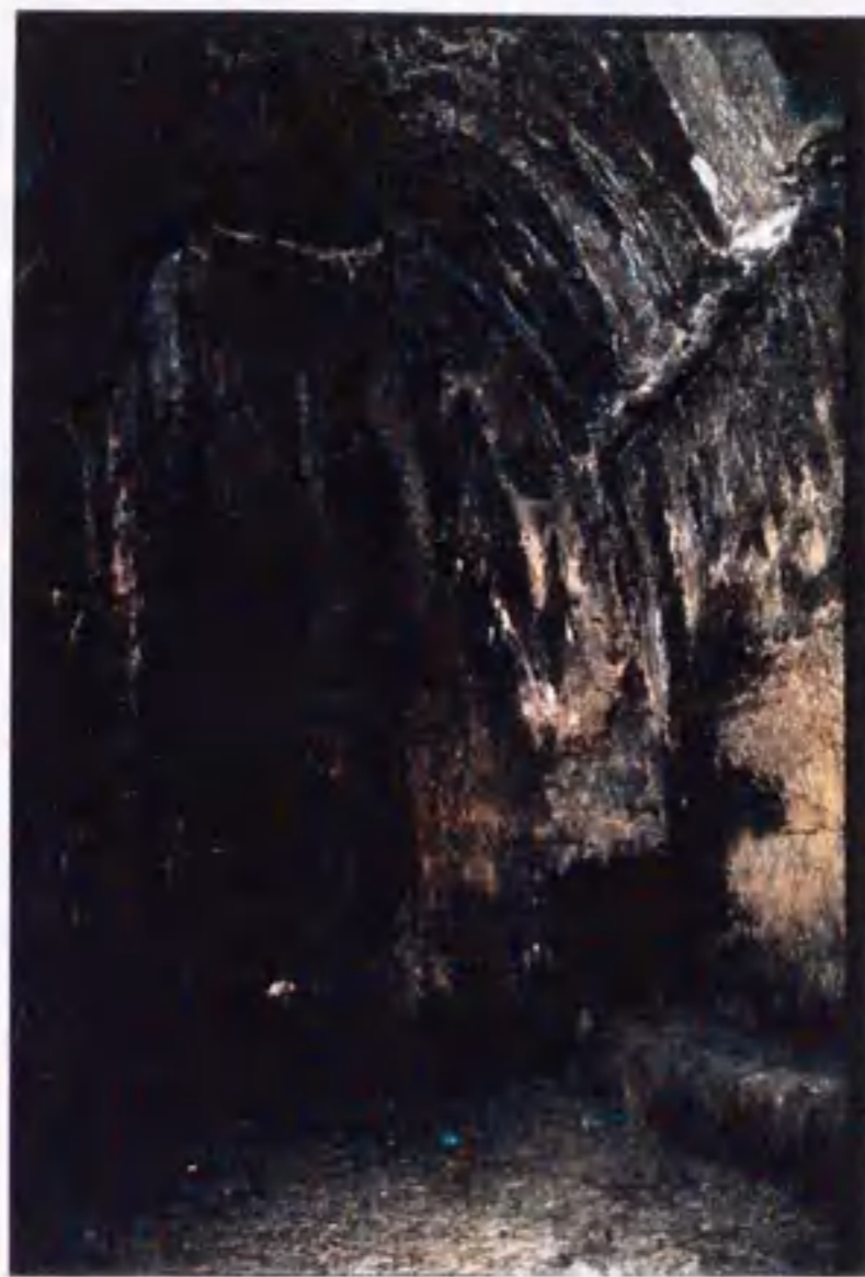
写真 1-2-19 ダムナール第12窟列柱廊後廊 ヴォールト状天井を有する房室
