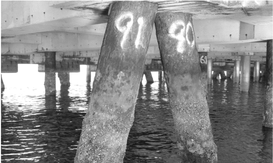
図 1.1 腐食した港湾鋼構造物の例
