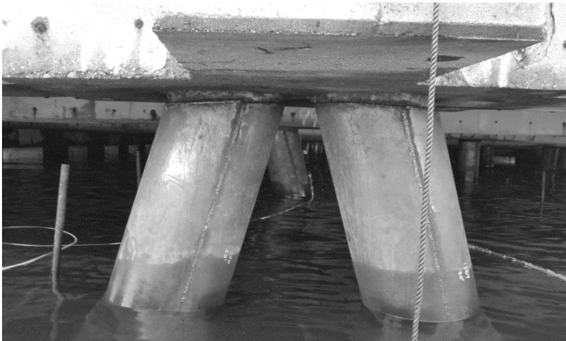
図 1.2 鋼板添接による補修された港湾鋼構造物の例
