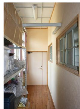
資料図 4-16-3 既設建具を再利用した新設間仕切り壁（右）
