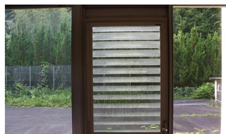
資料図 4-24-4 通風のため設置した外壁側の換気ジャロジー窓
