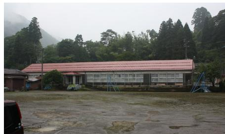
資料図 4-9-1 建物外観 外壁は羽目板で屋根は瓦棒葺き
