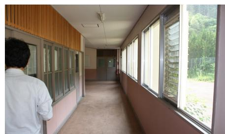
資料図 4-24-2 廊下 通風のため教室側及び窓側に換気窓を設置
