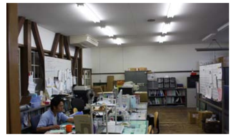
図 5-35 事務所内観 耐震ブレースが設置されている
