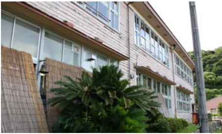
図 5-31 建物外観 建具はアルミサッシュに更新されている
