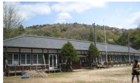
図 5-12 建物外観 基本的に竣工当時のままの姿を残している
