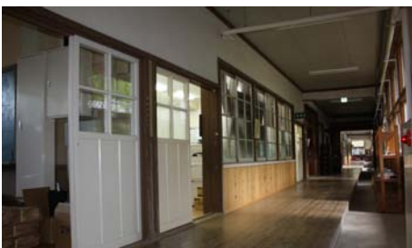
図 5-32 廊下内観 正面の旧教室が新設された工場部分
