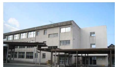
図5-2 右側にも校舎があったが消火活動実験後に撤去された
