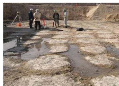
写真2.4-1 深層混合処理工法で地盤改良された後の対象敷地
