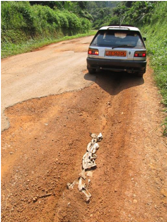
写真 5-2 レキエ県内の舗装道路 (アスファルトの損壊がはげしい)
