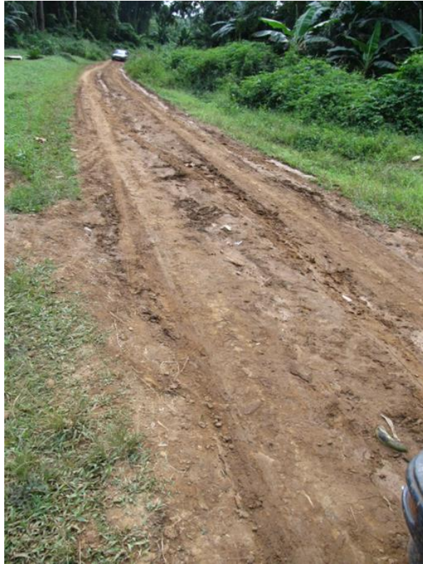
写真 5-1 レキエ県内の未舗装道路
