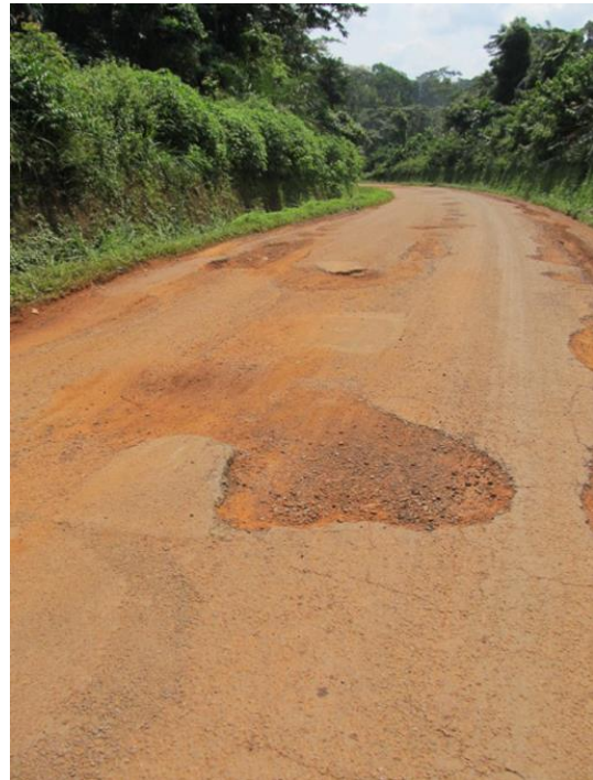
写真 5-2 レキエ県内の舗装道路 (アスファルトの損壊がはげしい)
