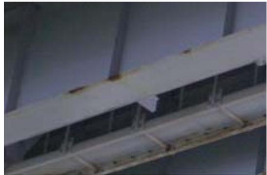
図-1 下フランジの発錆事例
