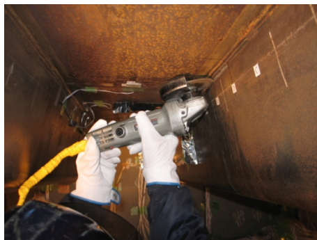
(a) ディスクグラインダーによる切込みの施工 (b) スリットと観察孔の施工状況
