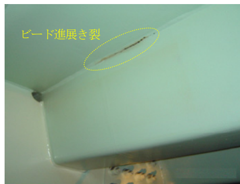
図-5.1 鋼床版のUリブ溶接部に沿って発生したビード進展き裂
