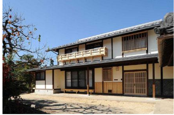
【大改修後】しっくい、桧材、粘土瓦により構築 1.
