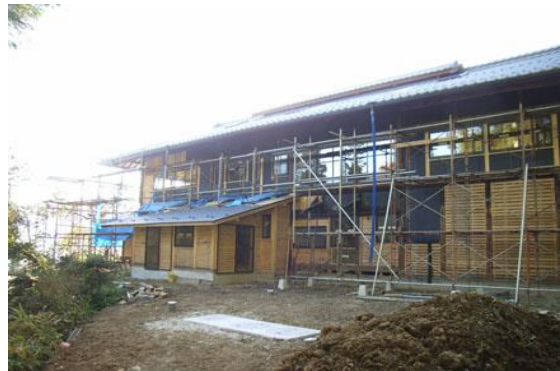
3. 【 東面外部、下地工事中 】
