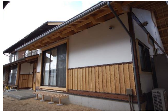
【大改修後 除却後、現代の軸組構法にて改築】 2.
