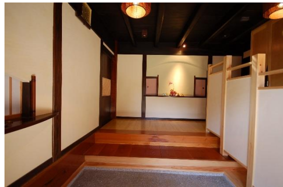
【大改修後 新たに玄関収納等も設置、改修】 3.
