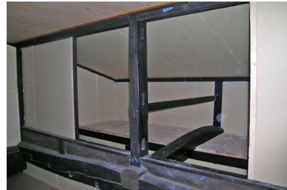
【小屋裏を利用した物入設置】
