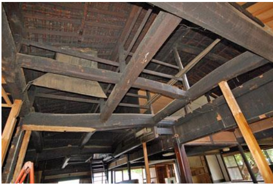
【 天井材は建築時のまま、炉の換気が見える 】 3.
