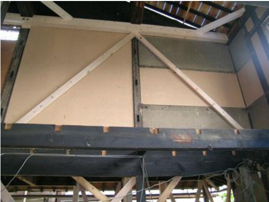
【 妻面を、軒桁・火打・筋違にて補強 】
