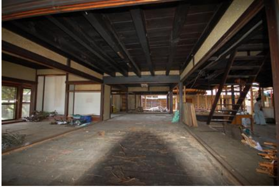
【 建具・タタミ撤去、モジュール形態がよくわかる 】 1.
