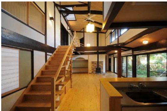
【大改修後】トップライトによる階段室への採光【5】
