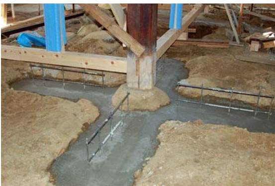
【配筋を施しコンクリート基礎を打設】
