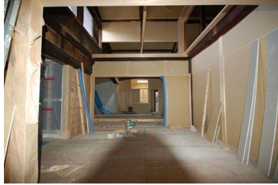
【「おへや」天井も撤去、吹抜空間へ】
