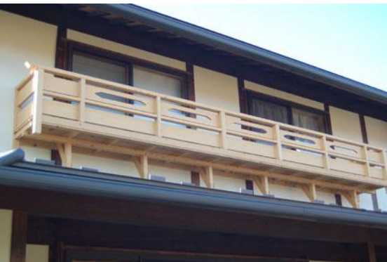
【大改修後】新規取付、桧材によるバルコニー
