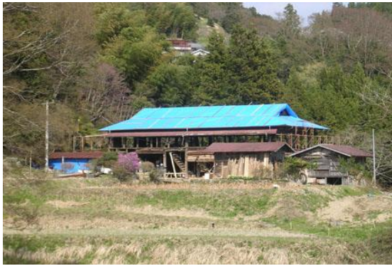
【 不要な壁を撤去した状態】
