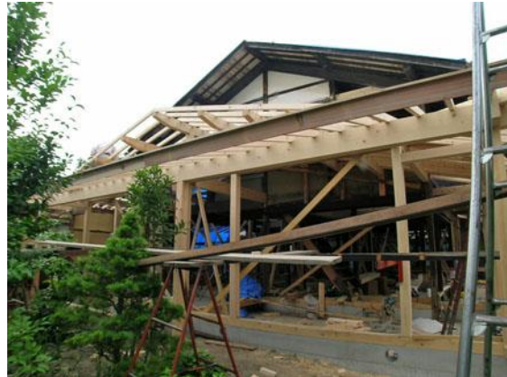
【 新材で組み上がった増築部 】
