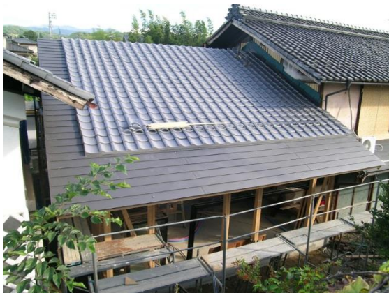
【粘土瓦葺き完了】
