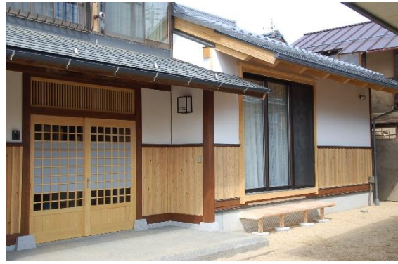
【大改修後 既存補強の上、現代の軸組構法にて改築】 1.
