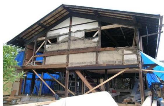
7. 【移築時増築部は除却】
