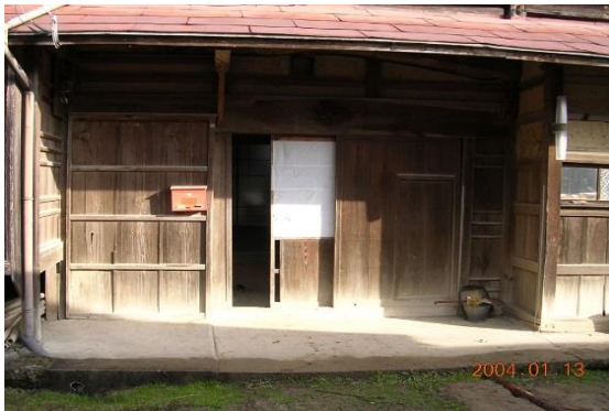
【大改修前 引き込み戸と障子戸による 当時のままの玄関】
