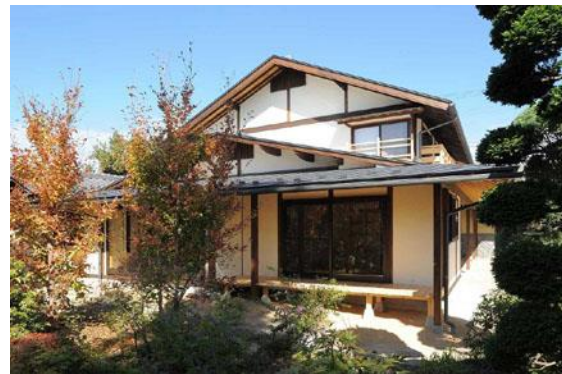
【大改修後】内部空間なりの切妻屋根に改修 2.
