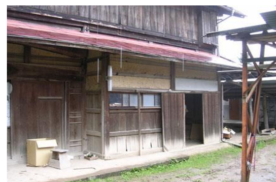
【玄関横の米貯蔵庫出入口】
