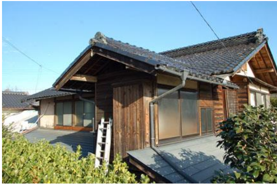
【 1962(昭和 37)年、2階便所増築部 】 3.
