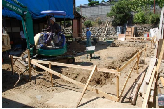
6. 【新築居間・食堂の基礎工事】 8.
