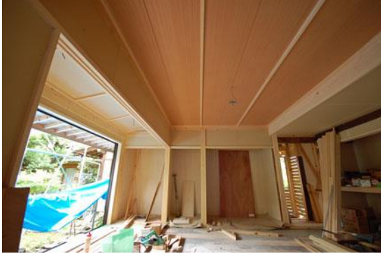
【 移築時増築部は和室仕上げ 】
