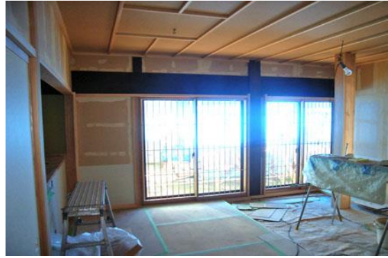
1. 【 1階、父母の部屋 木工事完了 】
