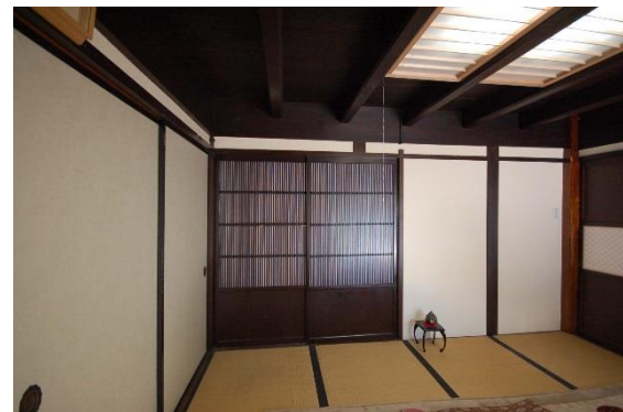
【大改修後 再使用格子戸、格子モジュール型は変わらない】 4.
