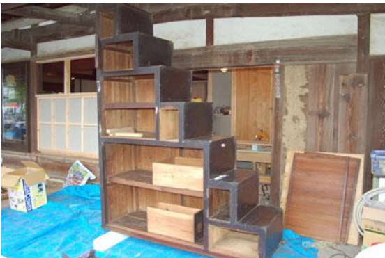
【箱階段を再使用する】
