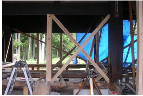
1. 【耐震補強の筋違】
