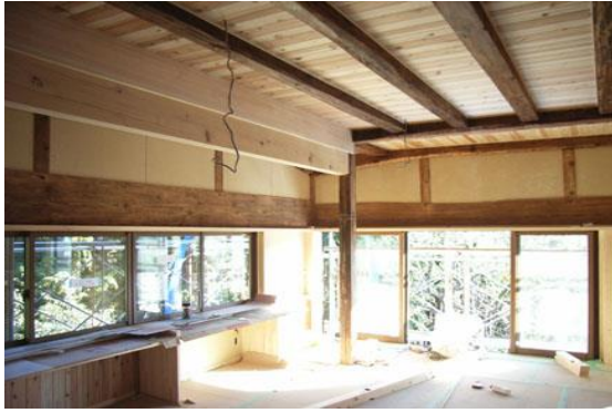
【 1階、居間 木工事完了 】
