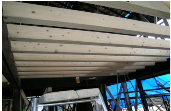
5. 【床梁を入れ替え、天井高を上げる】
