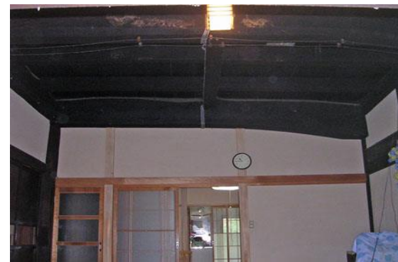
【和室・台所の改修部】
