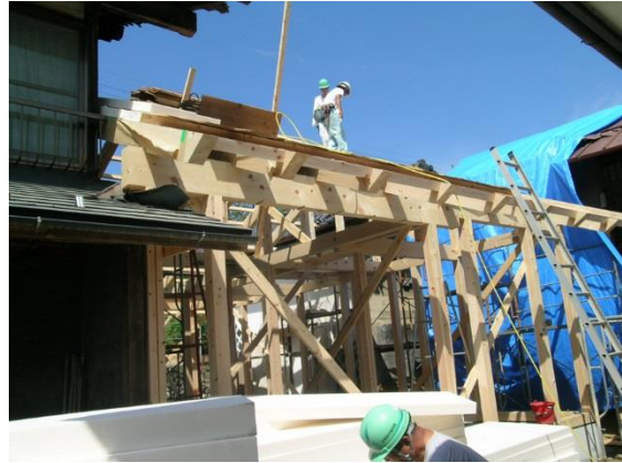
1. 【新築の上棟、7寸の登り梁を3尺間隔に架構】 2.
