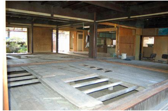
【 2階上座敷、建具・タタミ撤去 】
