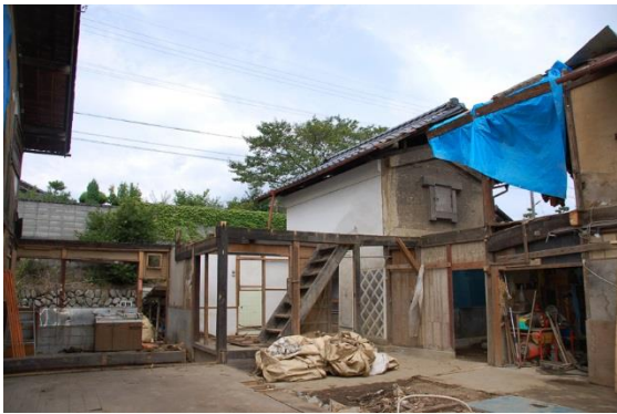
5. 【食堂、水廻りを解体した状態】
