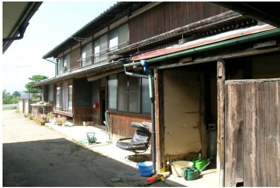
【大改修前 建築時のままの便所廻り】
