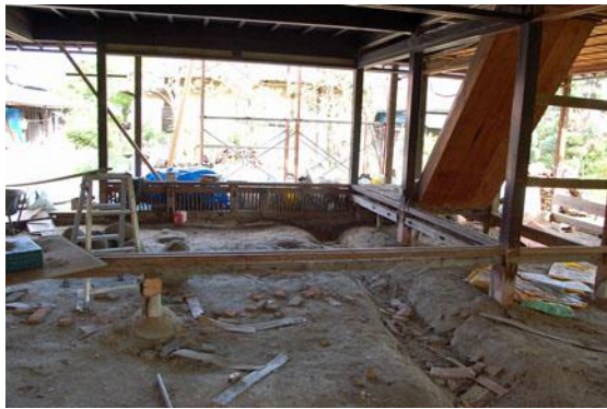
【 床廻り、再使用材を多用している 】
