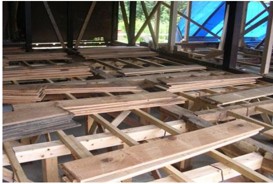
【床板は極力再使用】
