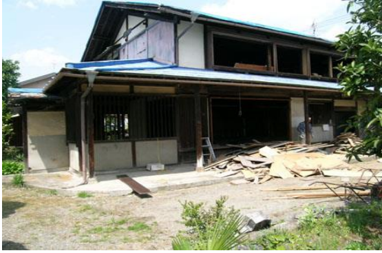
【 建具を取り払った状態 】
