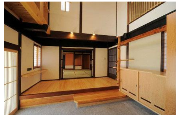
【大改修後】玄関部も床を撤去し、吹抜空間に改修【6】
