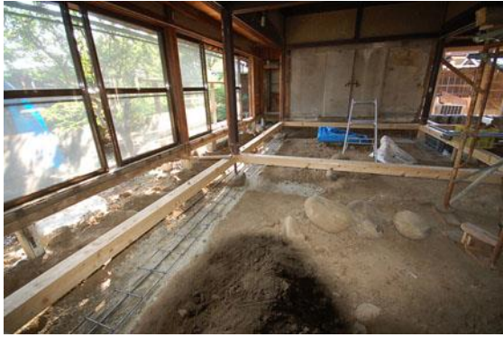
【 外周部の土台下には、コンクリート基礎を打設】
