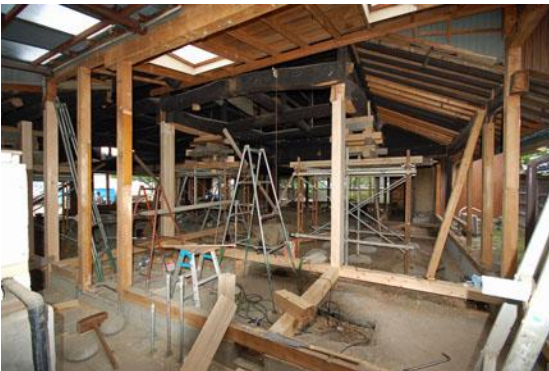
【足場で梁をささえ、基礎を施工】
