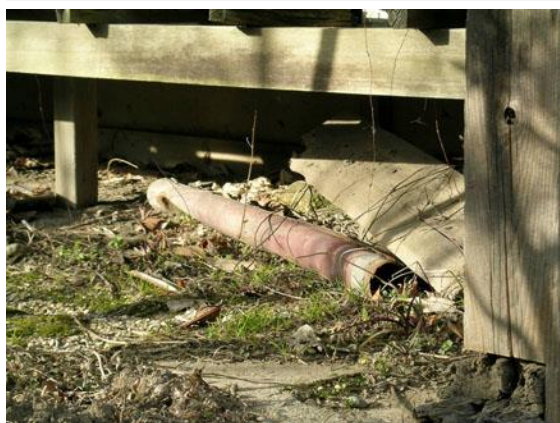
【 腐朽していない束・土台 】
