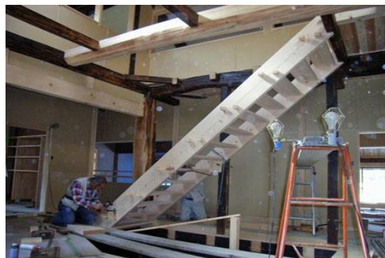
7. 【桧材による階段取り付け】
