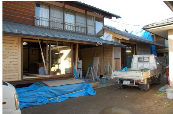
7. 【主屋の改修も進行中】 8.
