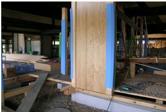
【 合板補強による耐力度の確保】
