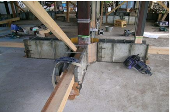
【大黒柱を中心に基礎補強】
