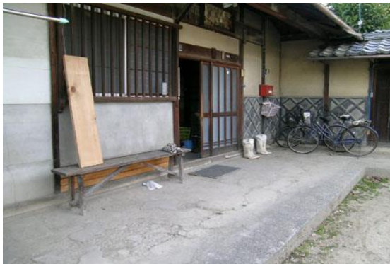
【大改修前】玄関部
