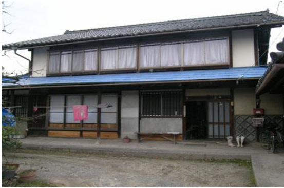
【 開口部がアルミサッシに改修された東立面 】 1.
