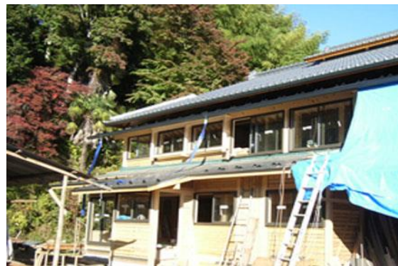
4. 【外部開口建具取り付け】
