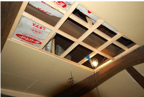
【1階天井裏には断熱材を充填】
