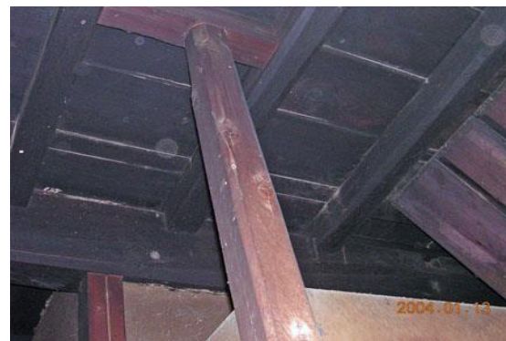
【 梁と一致しない新規間仕切り上部】
