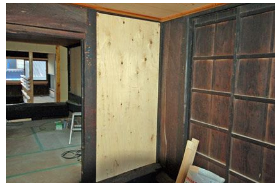
7. 【 合板補強による耐力度の確保】
