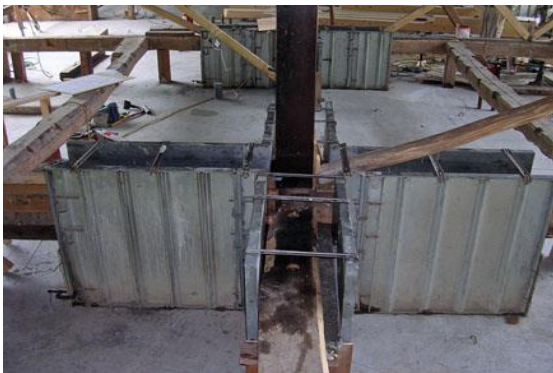
【 土台交換部の補強】
