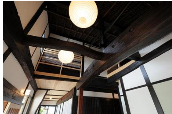
【大改修後 丸太梁露わしの吹抜空間を継承】
