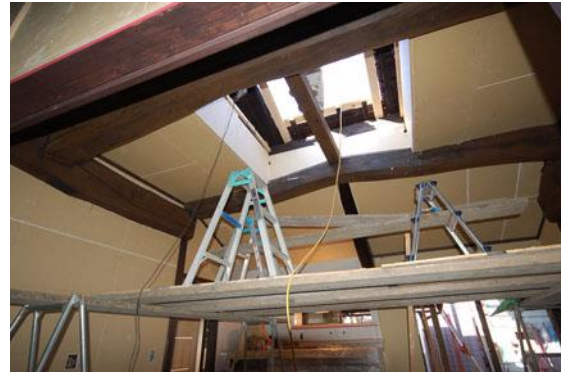
【父・母「居間・食堂」の天井にトップライトの取付】
