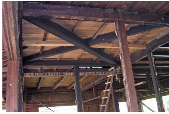
【 2階米倉天井の補強】
