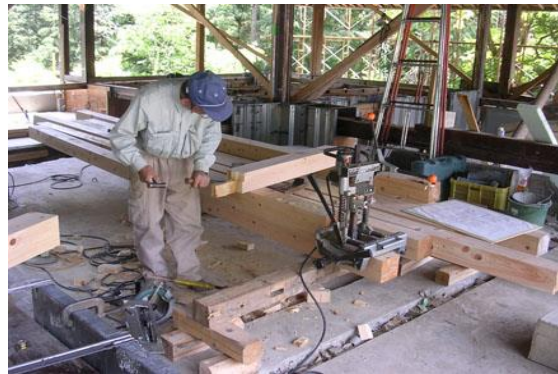
【 現場にて伝統工法の「ホゾ加工」】
