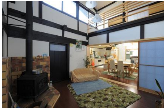
【大改修後 天井撤去、小屋裏と一体化する】
