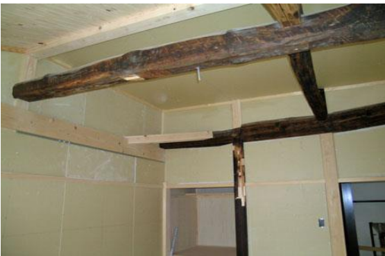
【 2階和室、木工事完了 】
