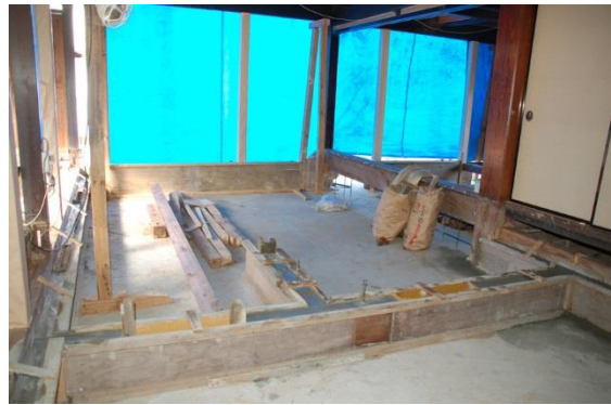
8. 【玄関ホールの基礎工事】
