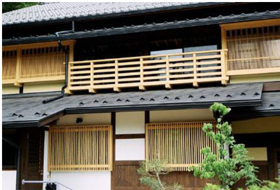
【大改修後 南信州産の桧材による各部造作材】 3.
