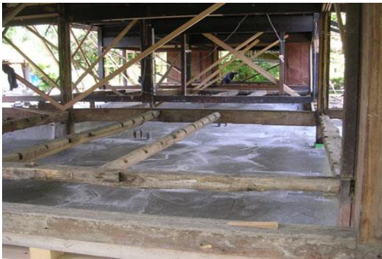
【 床下は、土間コンクリート打】
