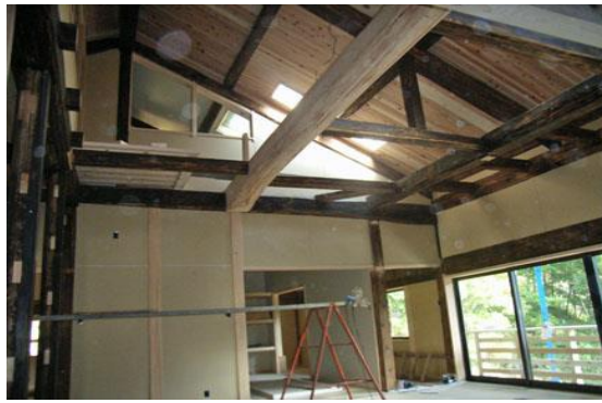
【 2階、吹抜ホールに改修 】
