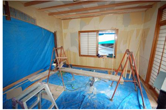
【 和室部木工事完了 】
