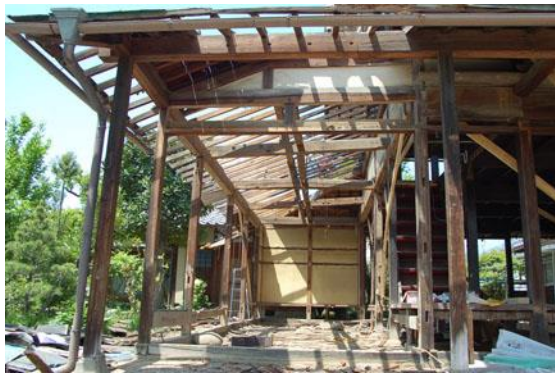
【 移築時増築部は、再使用材が大半 】
