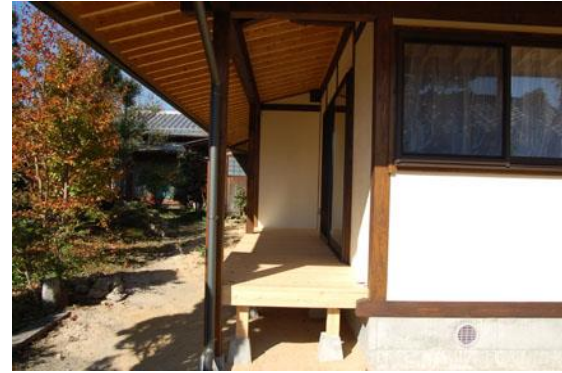
【大改修後】ヌレ縁を組み込んだ深い軒先空間 4.
