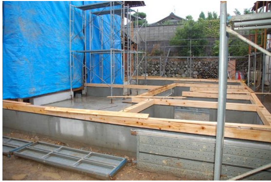
【新築居間・食堂の土台敷き】
