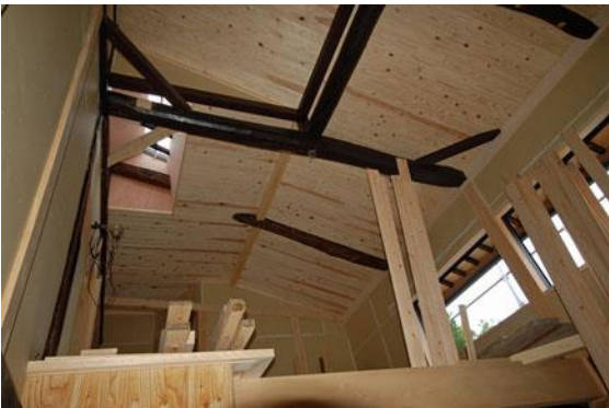
【 中の間・食堂は、松梁アラワシの吹抜へ 】
