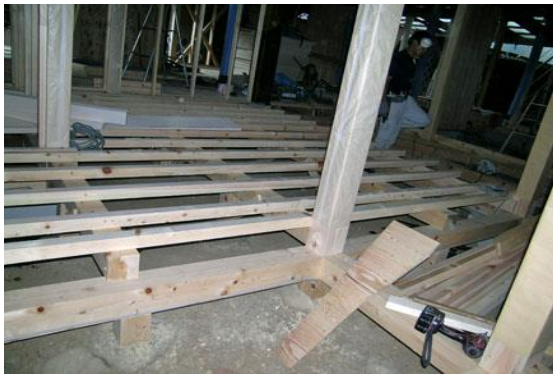
【 現代の在来軸組構法による床組み】
