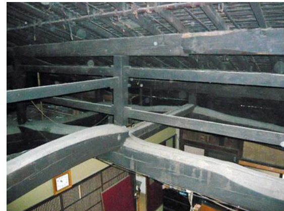
5. 【 建築時のままの天井・小屋組 】
