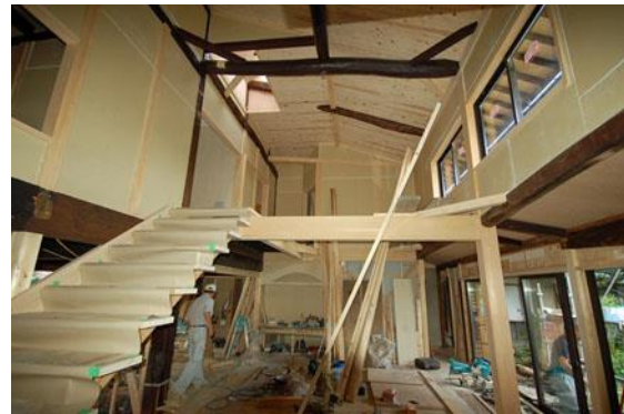
【 通し柱・床梁改修の吹抜空間 】
