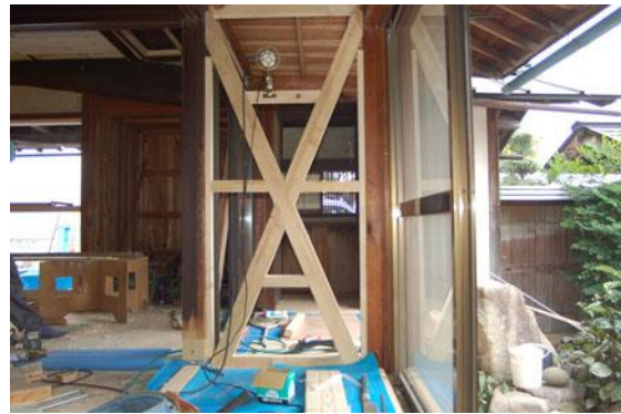
3. 【 新たな筋違による耐力度の確保】
