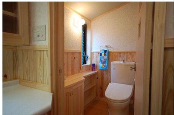
【大改修後 三畳を便所に改修】
