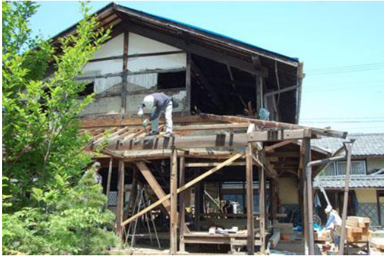
【増築部は大半を除却する】
