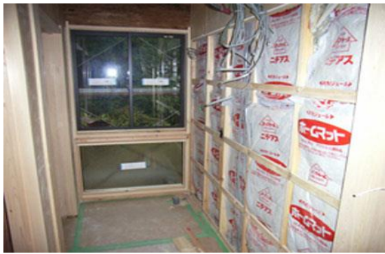
5. 【 外周部に断熱材を充填 】
