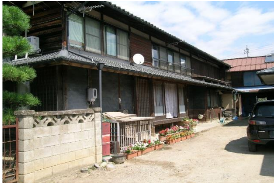
【大改修前 養蚕長屋と接続されたままの外観】
