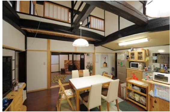
【大改修後 天井を撤去、建築時の小屋組を露わしへ改修】
