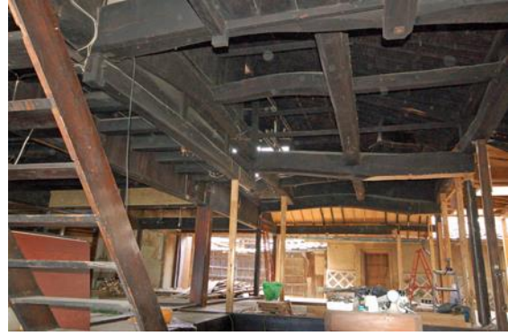
【 建築時からの丸太梁の状況 】 2.
