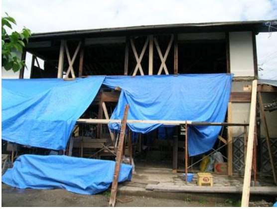
【 開口部に筋違を取り付ける 】
