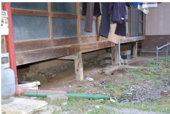
【 再使用材を多用した廊下廻り 】
