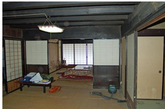
【 2階増床の為に架構された梁 】
