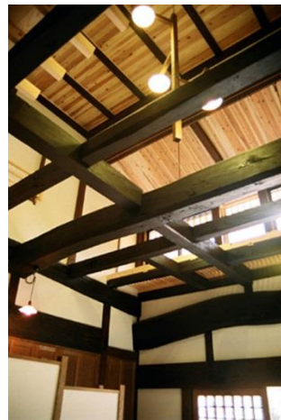
【大改修後 床を撤去、吹抜ホールに改修した玄関】 1.
