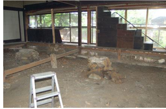
【 外周部は木舞土壁で区画されている 】 8.
