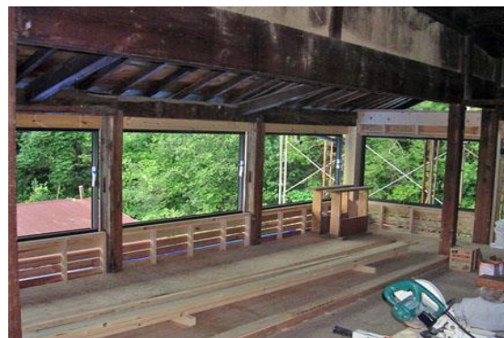
【 2階、回廊部の改修 】
