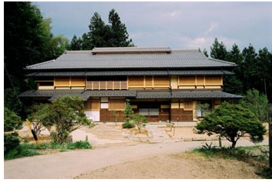
【大改修後 換気の越屋根を付加した外観】 1.
