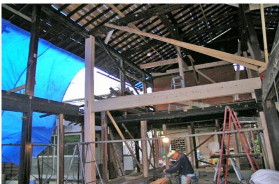
【通し柱を追加、床梁補強】
