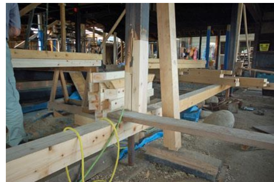
【老朽化した柱を継ぐ「根継ぎ」の構法】
