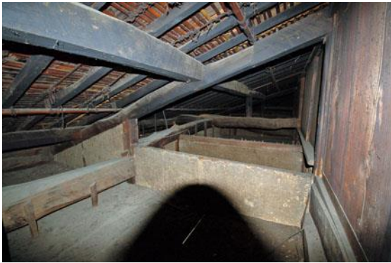
【 座敷上部の天井裏の様子 】 5.
