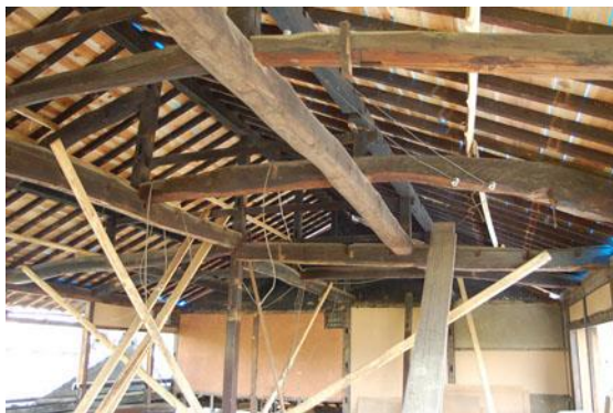
【 松丸太梁、梁材も再使用材が大半 】
