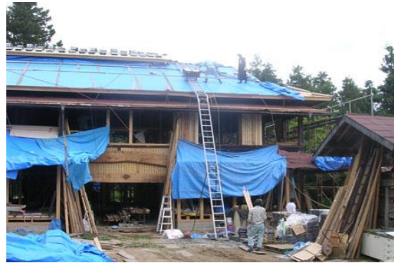
3. 【屋根は粘土瓦に葺き替え】
