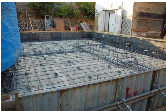
7. 【配筋工事完了】
