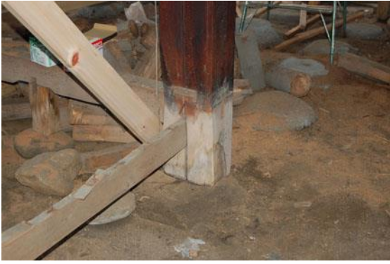
【大黒柱下部、乾燥地盤で劣化は無い】
