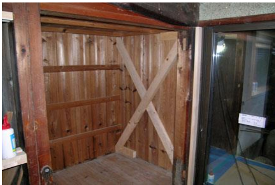
【 新たな筋違による耐力度の確保】
