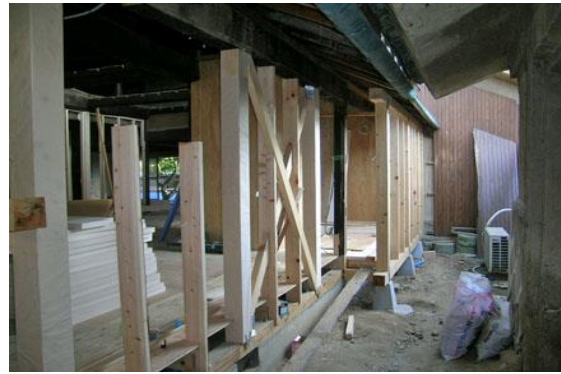
5. 【 新たな檜の柱、筋違による壁面構成】
