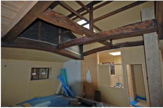
【天井を撤去、建築時の丸太梁を露出する】
