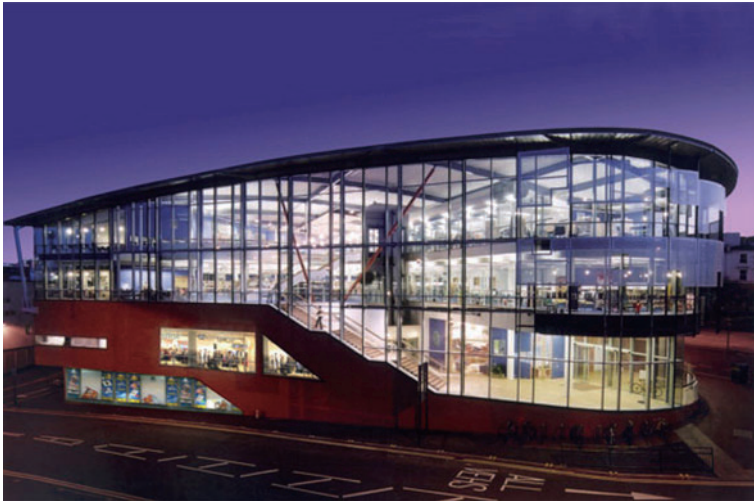
写真10 ボーマンス中央図書館の外観 (写真は図書館を設計したBDP(Building Design Partnership)のHP: http://www.bdp.com/ を引用した。)
