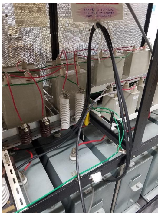
図 4-1 既存、新規コンデンサバンク。下の鼠色のコンデンサーが既存、上の白色のコンデンサーが新規。
