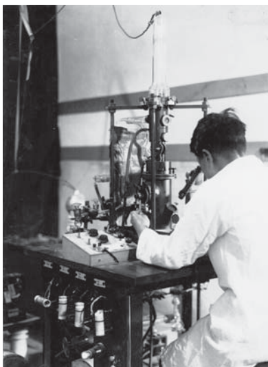
【写真③④】電子回折装置と著者（1943年4月撮影）。 設計……上田良二，高木佐知夫（1940年8～10月）。製作……理化学研究所（1941年11月完成）。1942年12月，名古屋帝国大学理学部物理学教室において組立を完了。
