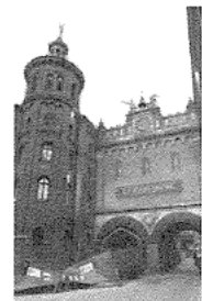
写真1 ディピロン・ゲートとダレルフ設計の醸造所
