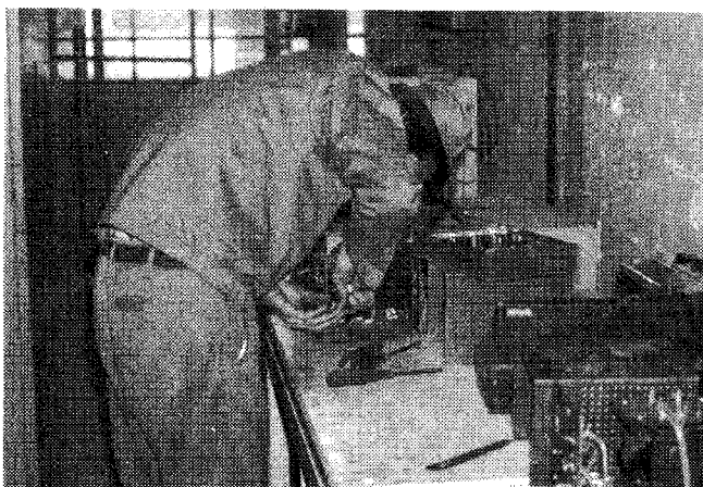
写真 2 - 10 卒業製作実習の光景 ( 溶接機設置・配線工事 )
