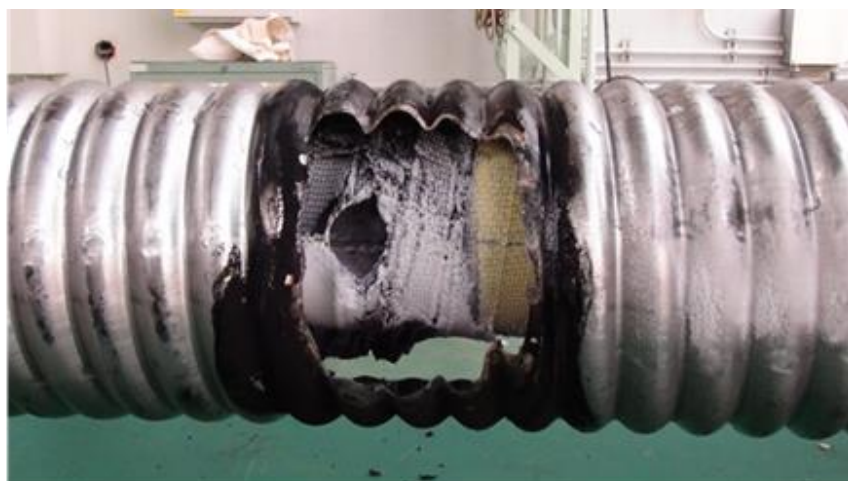
図 4.2.2-2 ケーブルコア試験後の状況
