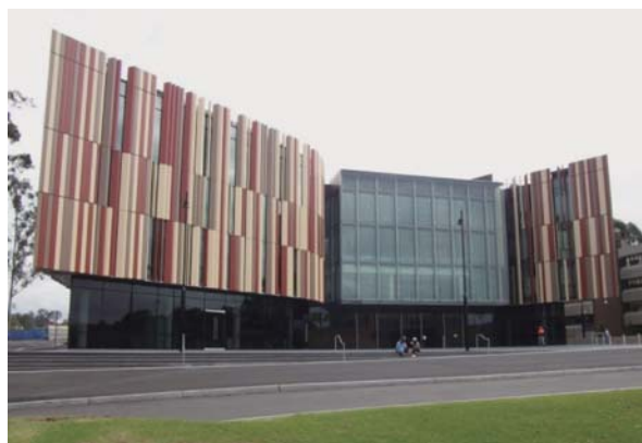
マッコーリー大学新図書館外観
