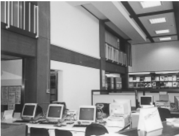
耐震のため増設された壁
