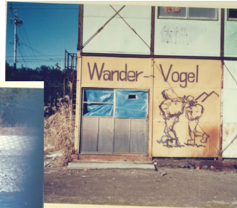
↑ 昔の部室 壁はぺらぺらの鉄板 窓には青ビニールが 張ってある
