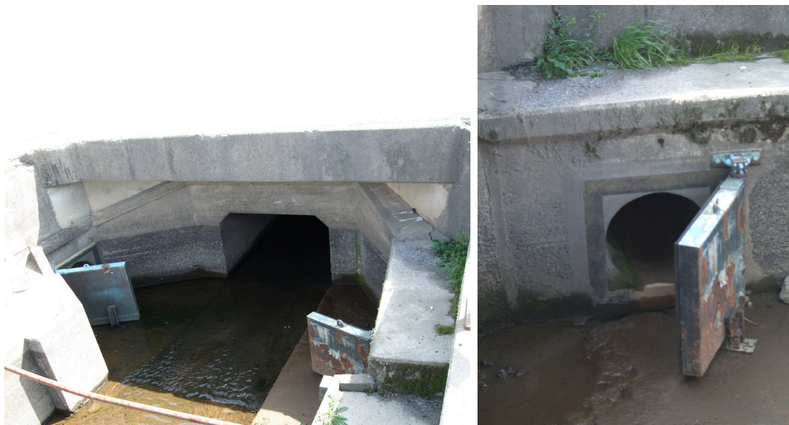
写真 2-4 輪中堤外へと流れる排水口（左）と逆水門の仕組み（右）
