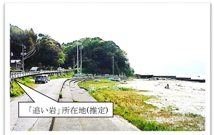
写真 4-1 五幡と江良の境界付近
