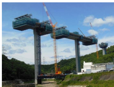
図-7.22. 張出し施工状況
