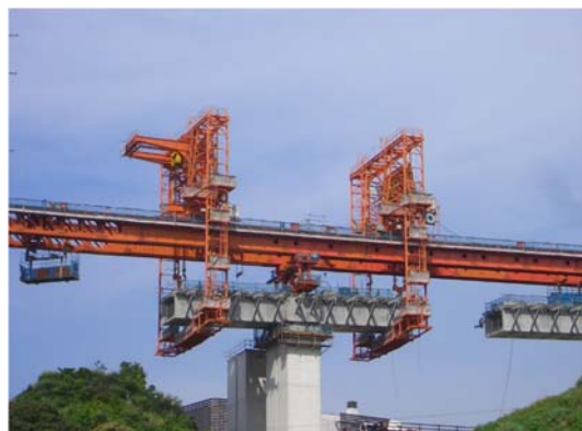
図-6.8. 張出し架設工法 (BCM)
