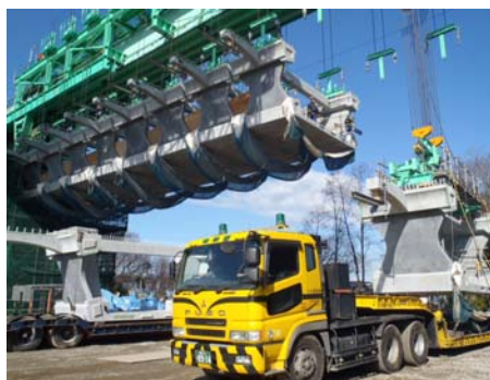
図-7.24. セグメント架設状況
