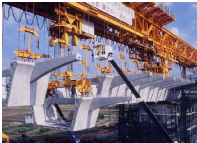
図-6.6. スパンバイスパン工法（SSM）
