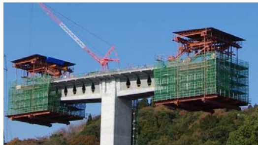
図-7.13. 張出し施工状況
