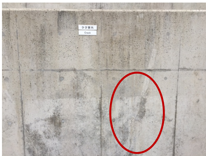
(a) コンクリート表面のひび
