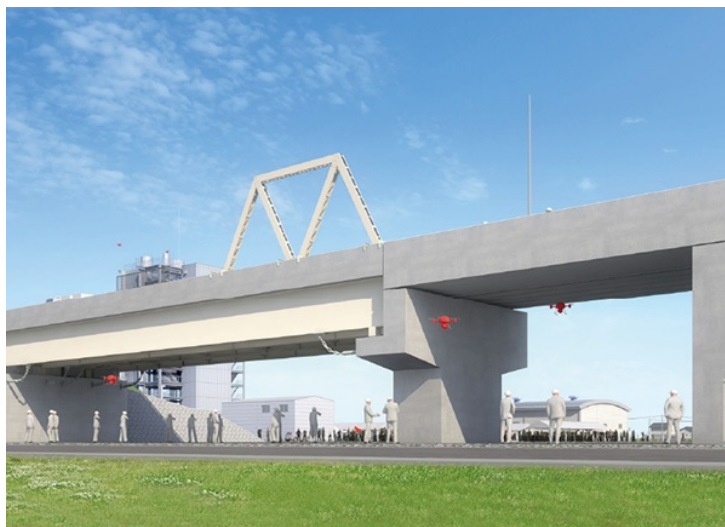
図 5.25. 橋梁を模した実験施設（写真：福島ロボットテストフィールド）
