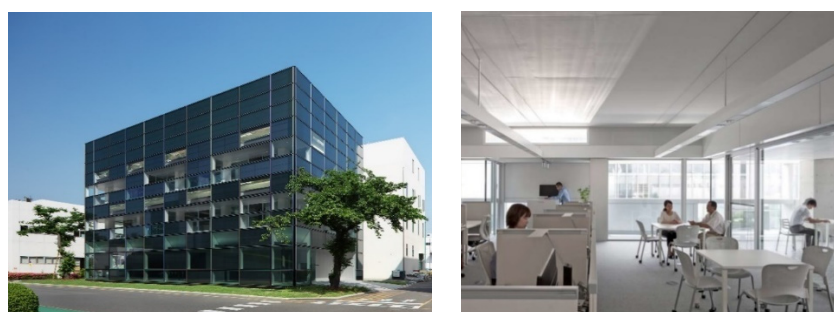
写真 2.2-1 建物外観・内観
