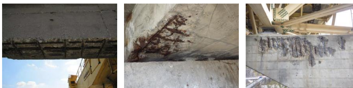
図-3.1 せん断補強筋が腐食した構造物
