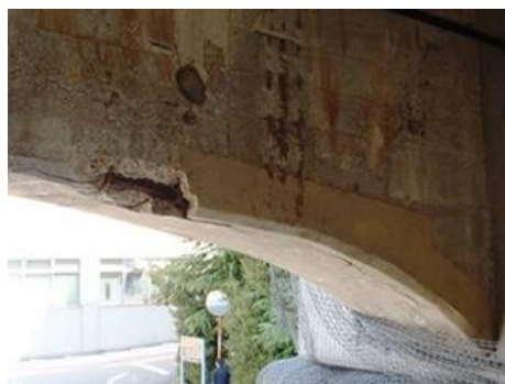
図-1.3 軸方向鉄筋が腐食した RC 梁
