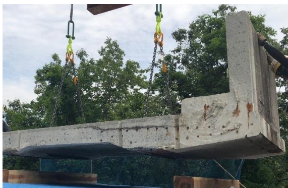
図-1.5 RC 床版のひび割れ状況
