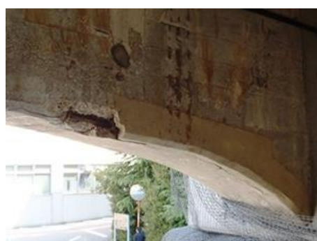
図-2.1 軸方向鉄筋が腐食した RC 梁
