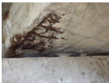
図-1.4 せん断補強筋が腐食した構造物
