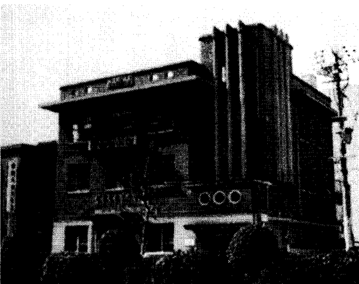
愛知県名古屋労政事務所 (1931年＝昭和6年竣工/愛知県営繕課)
