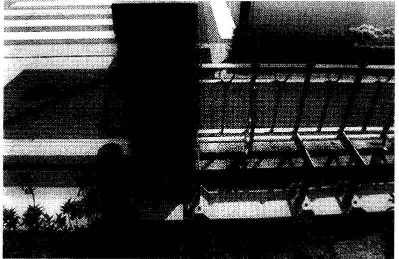
煉瓦囲障の構造補強 鉄柵も新設の擁壁に取り付け
