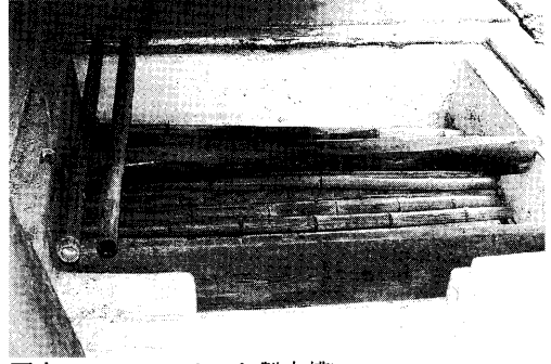
写真20 コンクリート製水槽
