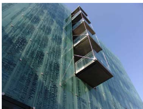
図 6.2-7 総ガラスのビル
