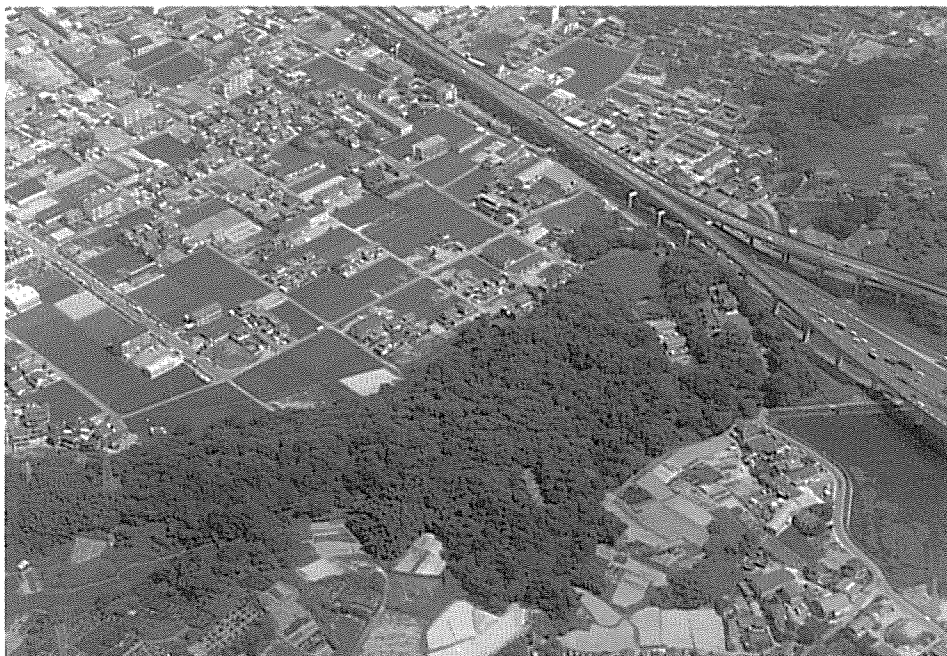
写真0-3. 本研究を行った森林およびその周辺. 名古屋行全日空機より撮影 (1989年 8月). 左上が北. (本文0-2-1)
