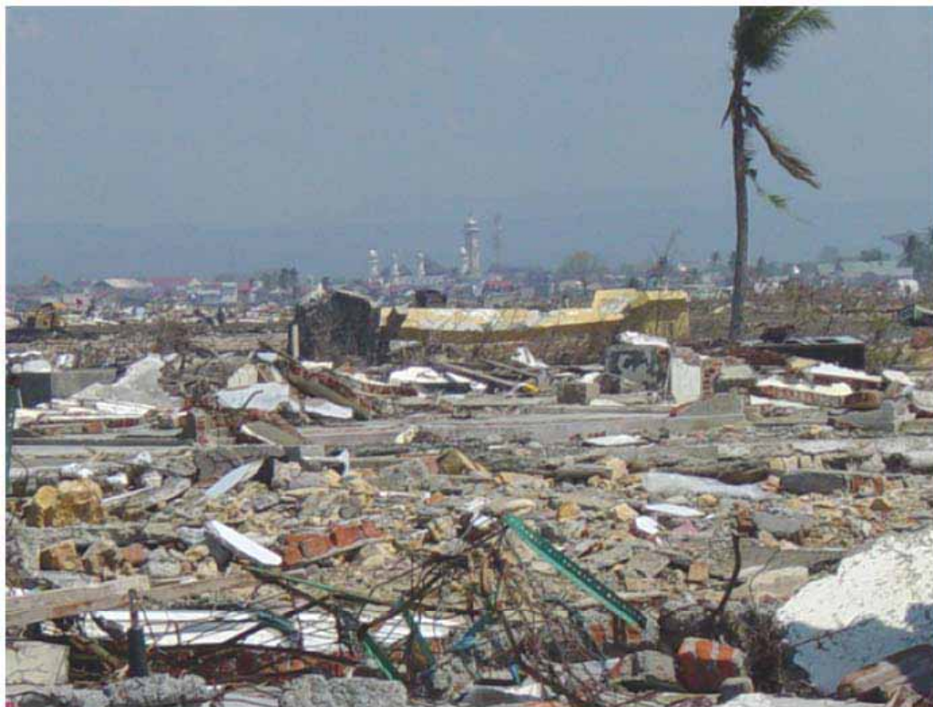
写真1 海岸から市内中心部を見る。中央モスクまでの間に、建物がなくなっていることが分かる。(2005.2.8. Farid MURANA 撮影)
