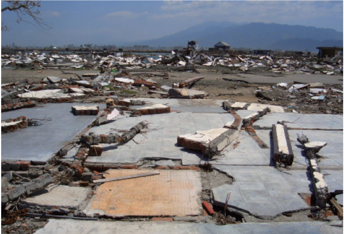
写真1 2005年2月時点のウレレ港湾近くの住宅地跡 津波が通った後が、鉄筋の押し曲げられた方向でよく分かる。
