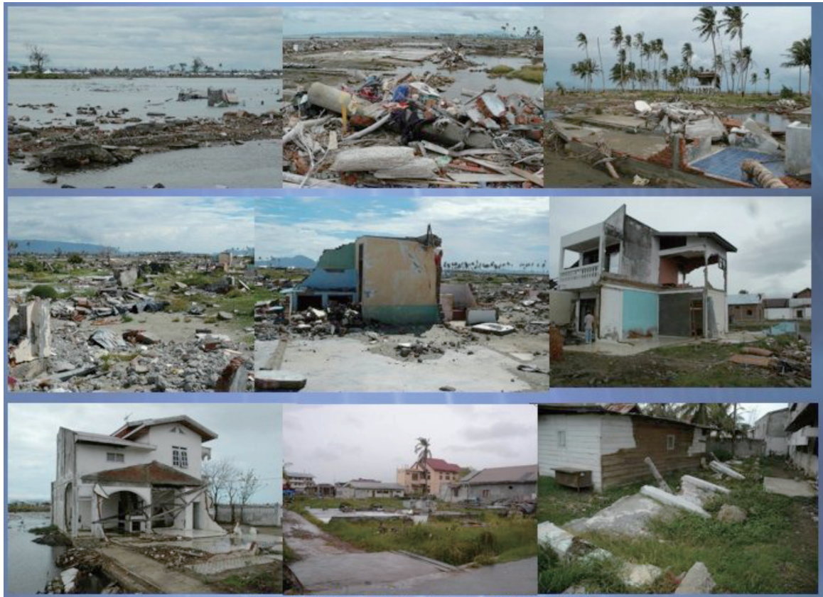
図8 バンダアチェ平野における海岸から内陸に向けての被害の変化 Fig. 8 Damage of buildings from the coast to the inland in the Band a Aceh Plain
