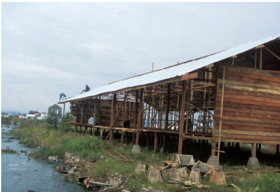
写真7 2005年12月 建設中の仮設住宅
