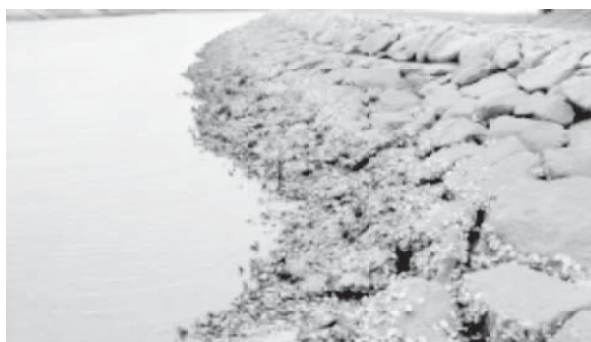
図 3-33b. 調査地点 田中川の状況 (2002 年 5 月 29 日 河口部の人工護岸を撮影)
