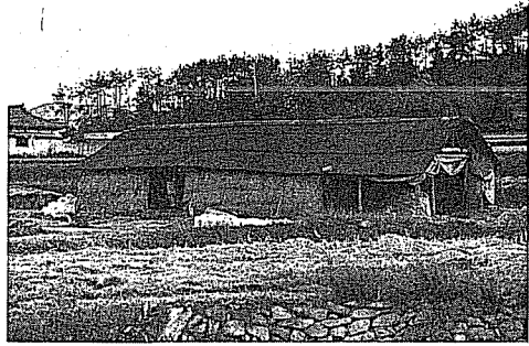
2. 瓦製作の作業場
