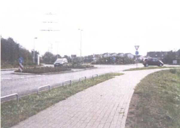
写真 6.6 環道, 及びエプロン(Babenhausen)
