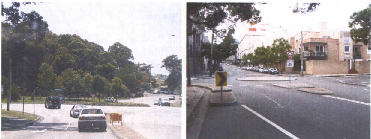
(a) 郊外幹線道路の片側2車線のラウンドアバウト (b) 市街地細街路のMini roundabout(Sydney) (The Entrance)
