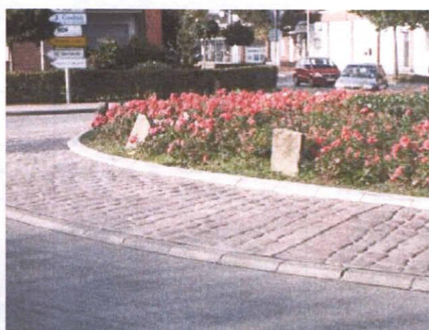
写真 5.2 中央乗り上げ防止のための障害物 (独:Borken)
