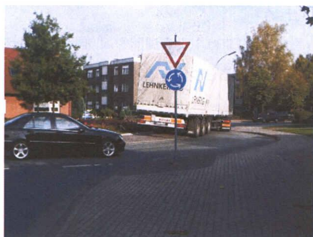
写真 5.9 エプロンに乗り上げる大型車 (独:Borken)
