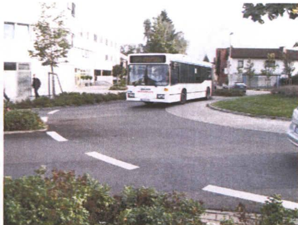
写真 5.8 エプロンに乗り上げる大型車 (独:Dieburg)
