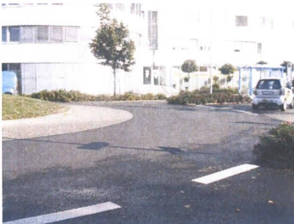
写真 6.10 環道, 及びエプロン(Dieburg-1)
