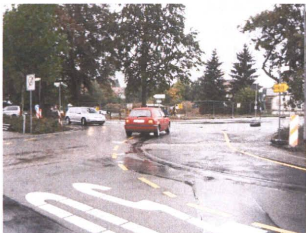
写真 6.13 無信号交差点をラウンドアバウトへ改良
