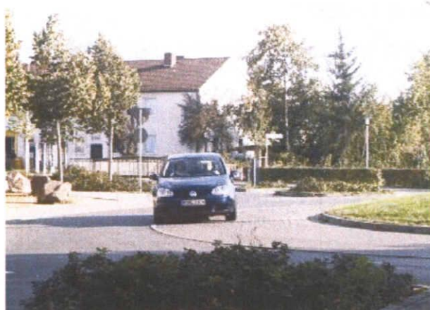
写真 5.11 エプロンが乗用車により利用される (独:Dieburg)
