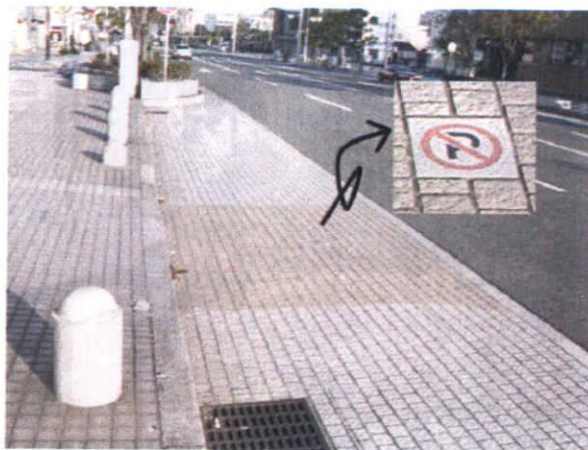
図 2.9 路上駐車スペースにおける路外施設 出入口部分の対処例(山口県宇部市)
