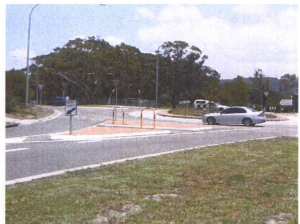
写真 5.16 郊外のラウンドアバウト流入部 (豪:The Entrance)
