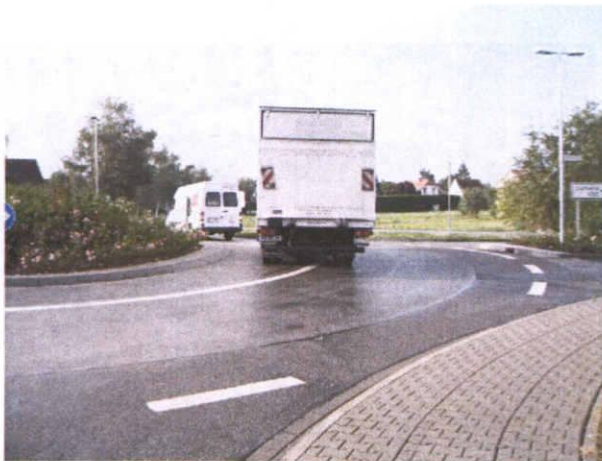
写真 5.7 エプロンに乗り上げる大型車 (独:Babenhausen)
