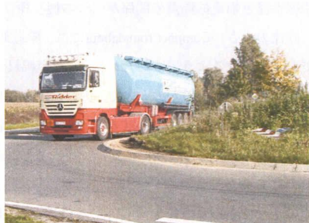
写真 5.12 エプロンが設置されていない事例 (独:Borken)
