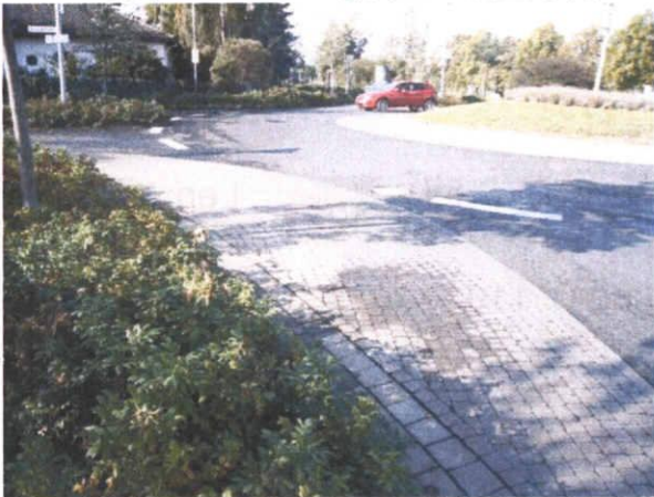
写真 6.8 流入部の切り欠き(Dieburg-1)
