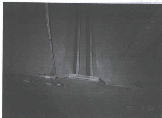
写真 5.5 仮支承用ソールプレートおよびガセットプレート
