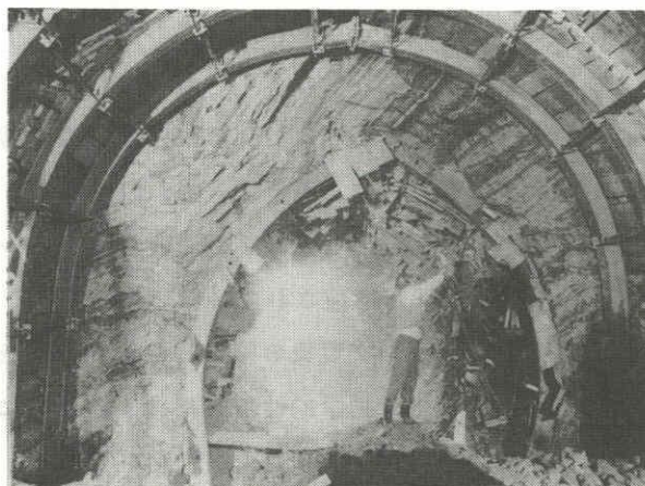
図 2.4 層状岩盤内のトンネルにおけるキンキングの発生 (泥岩；長野県岡谷市 塩嶺トンネル)
